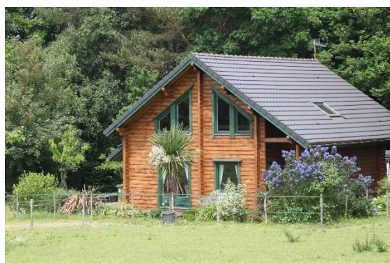
Illustration d'une maison pendant et après embellissement
