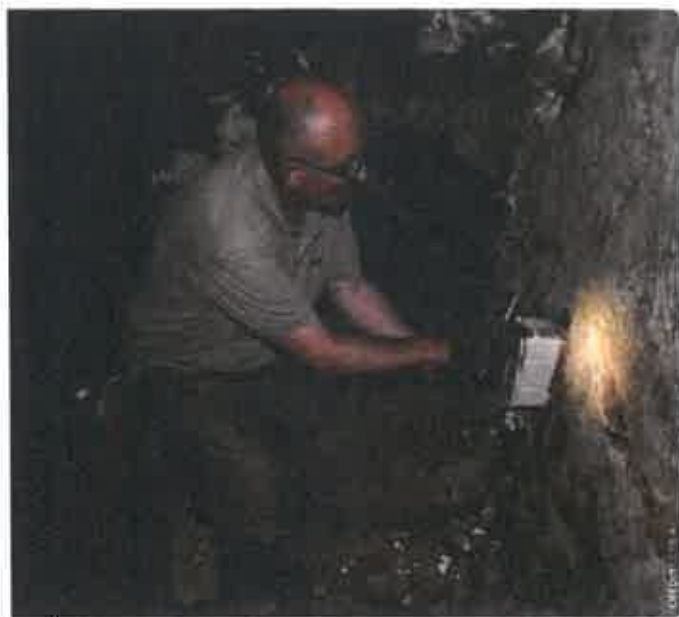
VÉRIFICATION DE LA CONNEXION DES STATIONS MURALES
