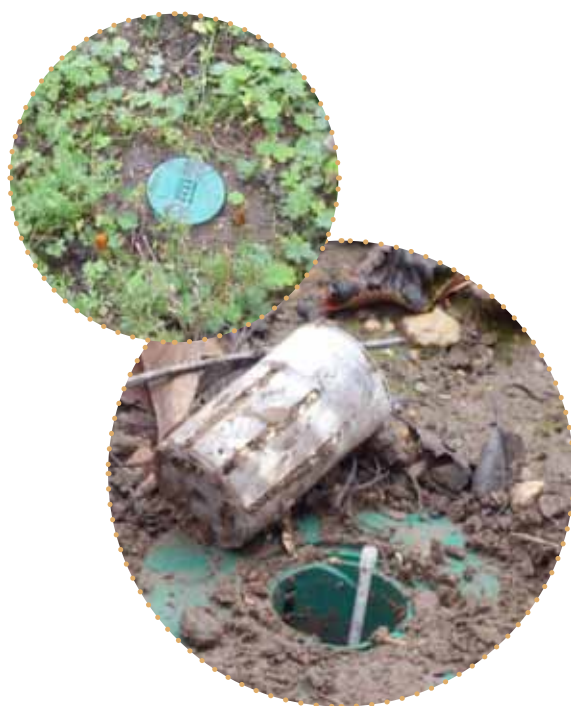
Traitement curatif par piège
