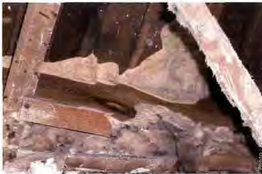
▲ Dégâts de la méréule.
